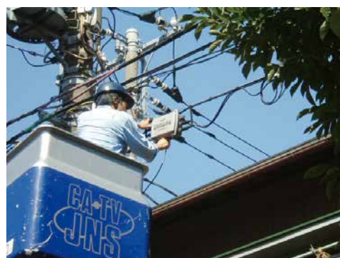
電気通信工事
